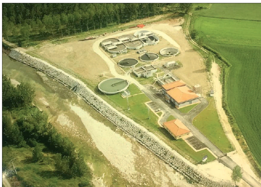
Vista aérea de la EDAR de Medina de Pomar.
