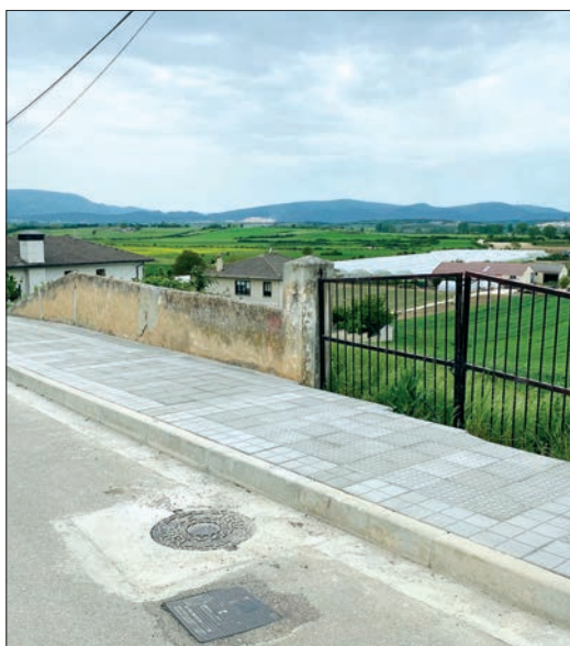
En las calles Proncillo, Gaspar Ruiz de Pereda y La Revilla, se llevó a cabo la renovación de redes, alumbrado y aceras.
