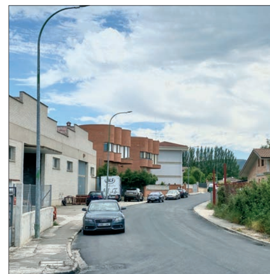
Asfaltado de la calle Merindad de Montija.
