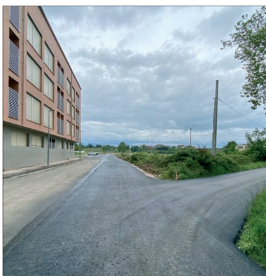
Asfaltado de la calle Velázquez.
