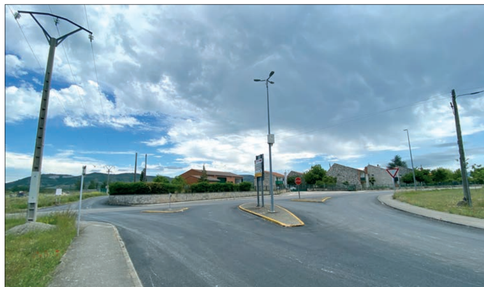
Acceso al Polígono Industrial “Las Navas”.
