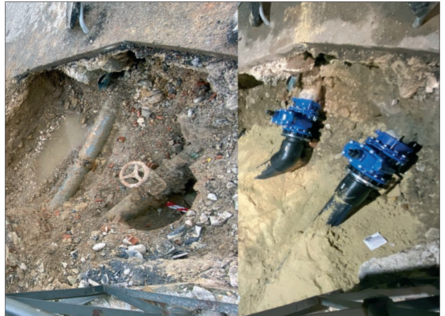
Renovación de redes en la Avenida de La Ronda.
