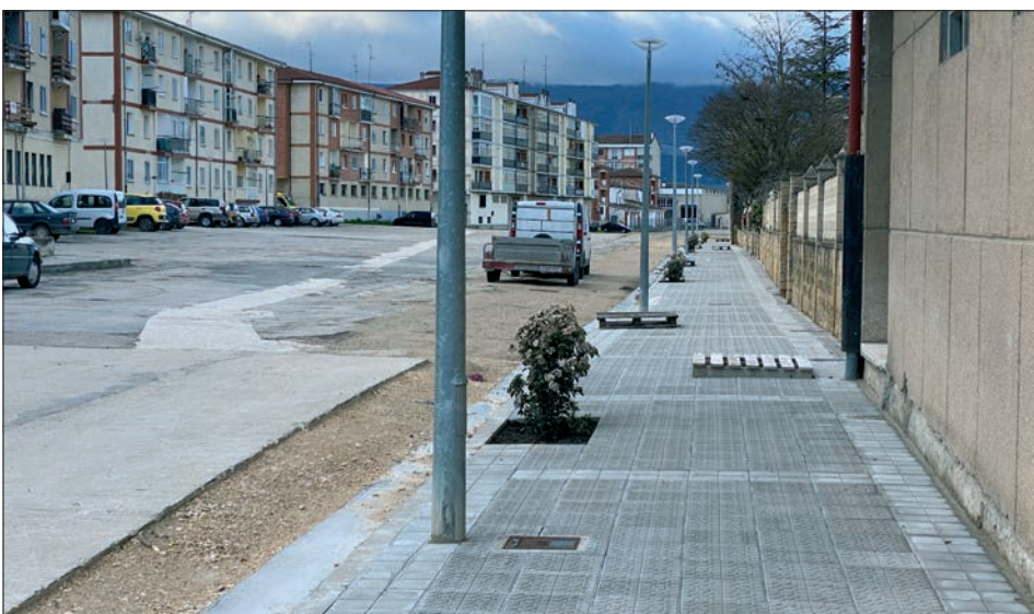
Acera perimetral el “El Ferial”.
