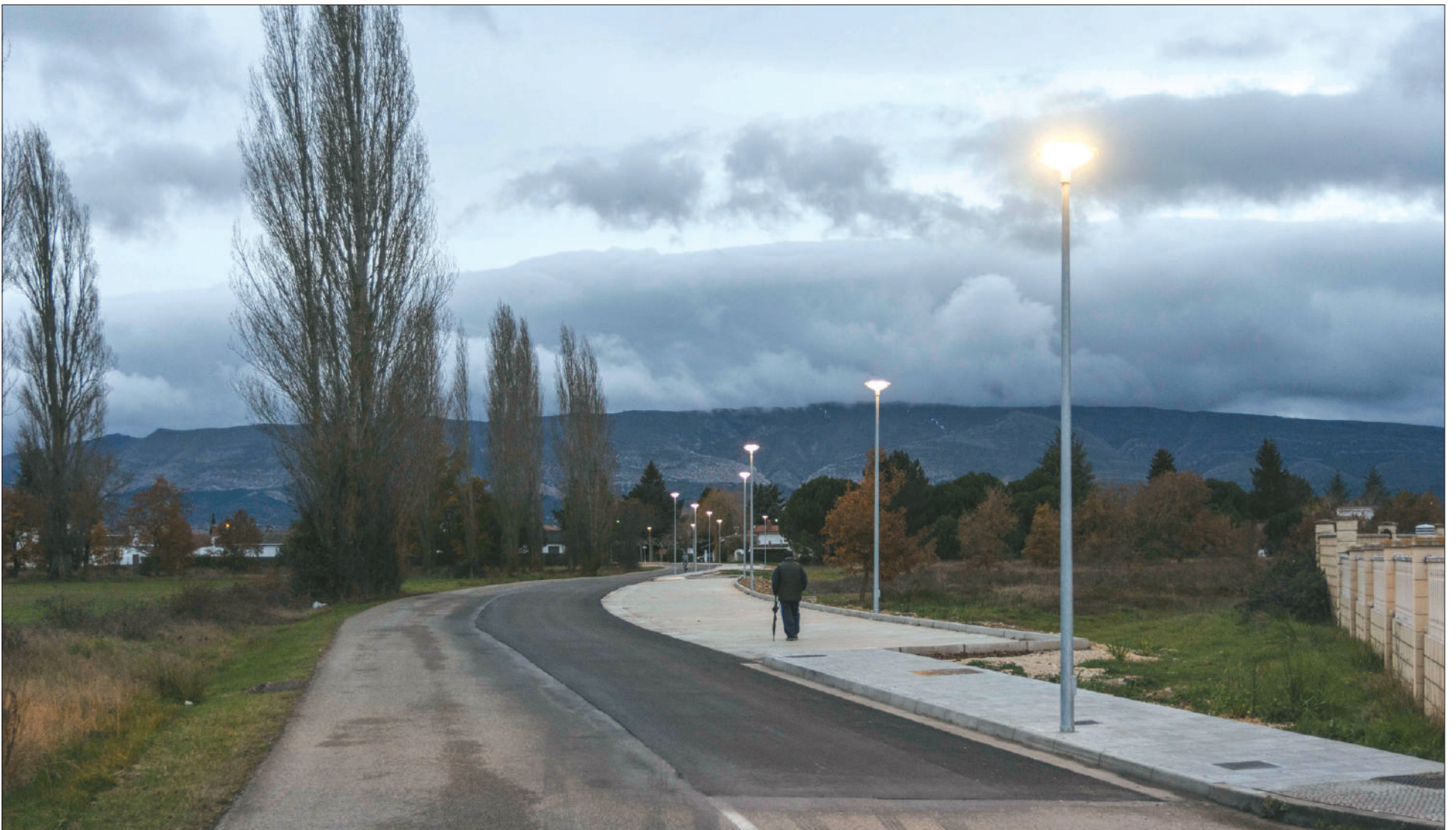
Una de las obras más importantes del año ha sido la de mejora de la seguridad y accesibilidad de los peatones en la Avenida Vizcaya en la que el Consistorio invirtió más de 162.000 euros.
