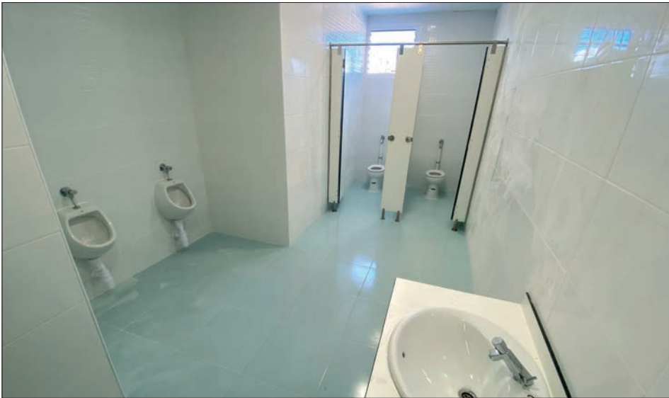
Obras de reforma y mejora en los baños del CEIP San Isidro.
