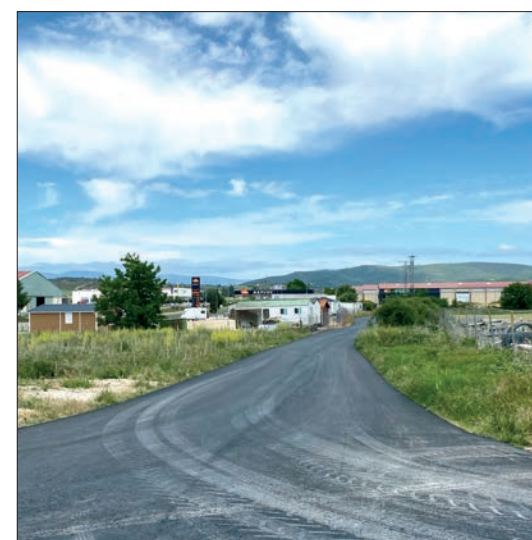
Asfaltado de la calle La Coruña.
