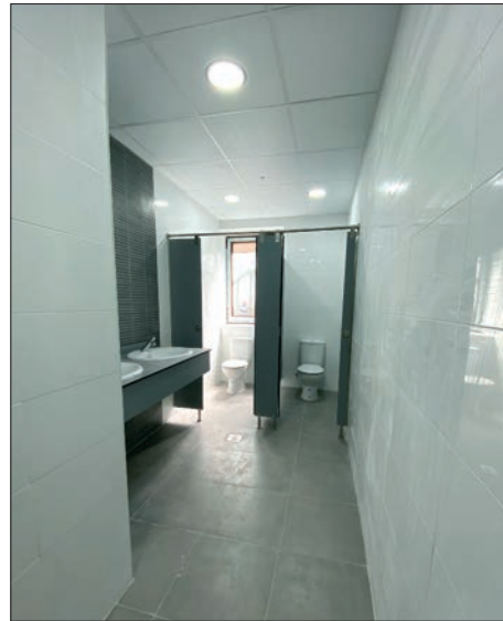
Obras de reforma y mejora en los baños del IES la Providencia.
