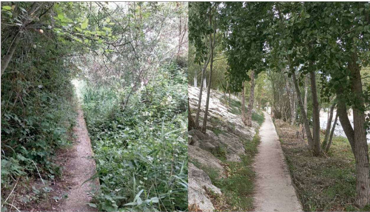
Aspecto que presentaba antes y después de los trabajos de limpieza el camino de hormigón paralelo al río Trueba.
