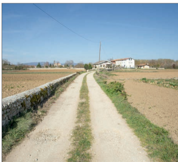
Antes y después del asfaltado de uno de los caminos de acceso a Villacomparada.
