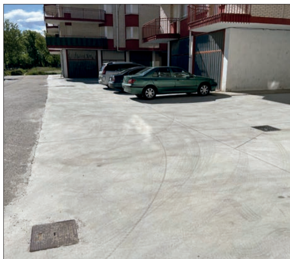
Obras de pavimentación y mejora de las infraestructuras subterráneas en la calle Díaz de Vivar.
