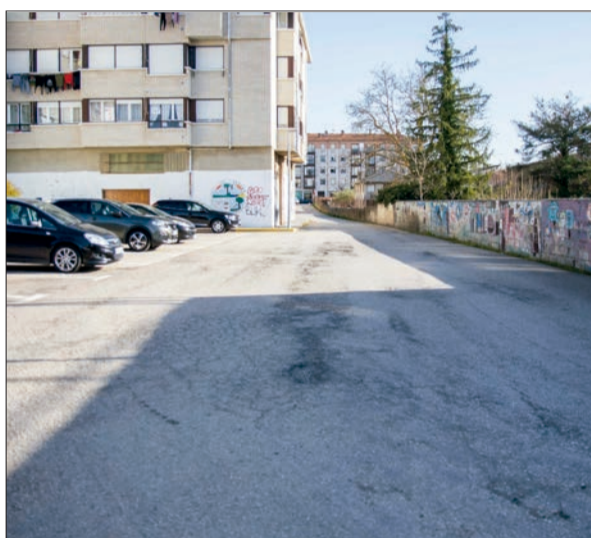
Antes y después del asfaltado de la calle Alvar Fañez.
