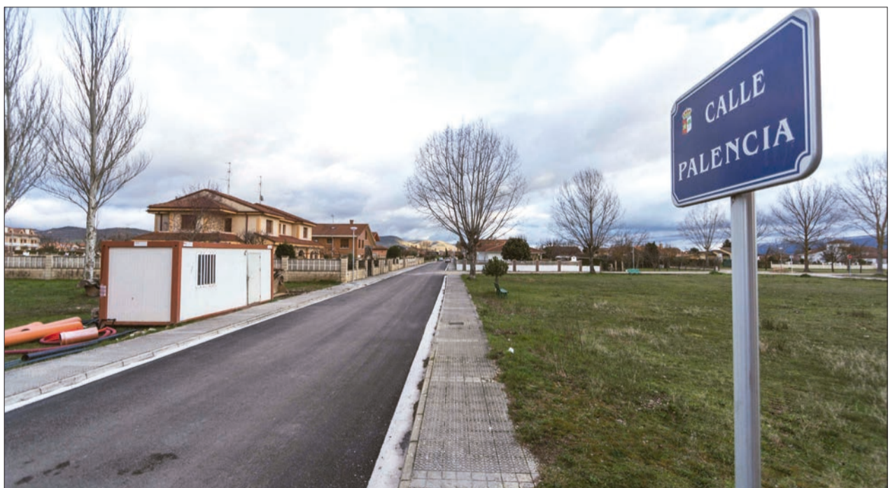
En la urbanización “Granja San Pedro” se han ejecutado en dos fases, una obra “de gran importancia, ya que las viviendas sufrían los perjuicios de no tener los servicios mínimos necesarios”.
