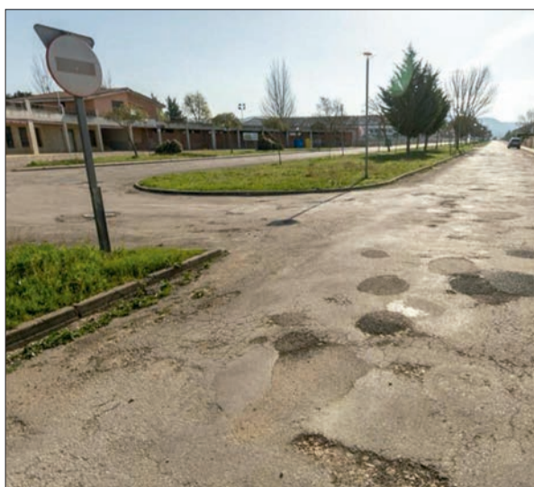
Antes y después del asfaltado de la calle santo Domingo de Guzmán.
