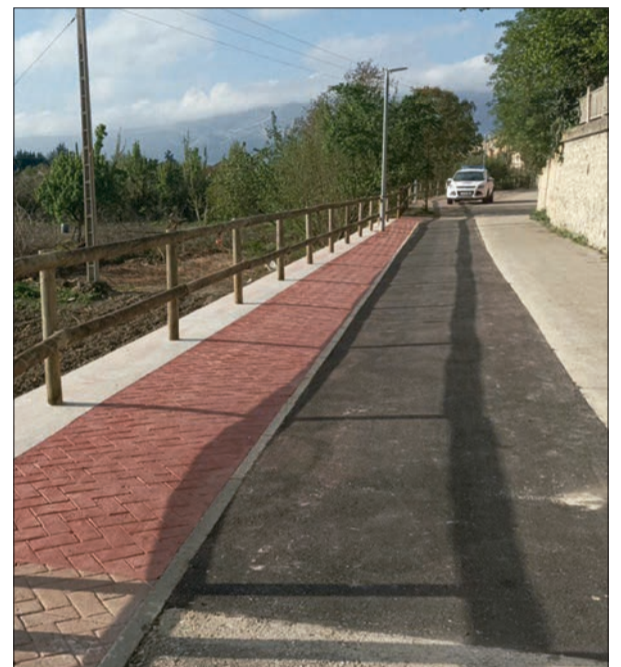
Arreglo del tramo hundido en Tras las Cercas.
