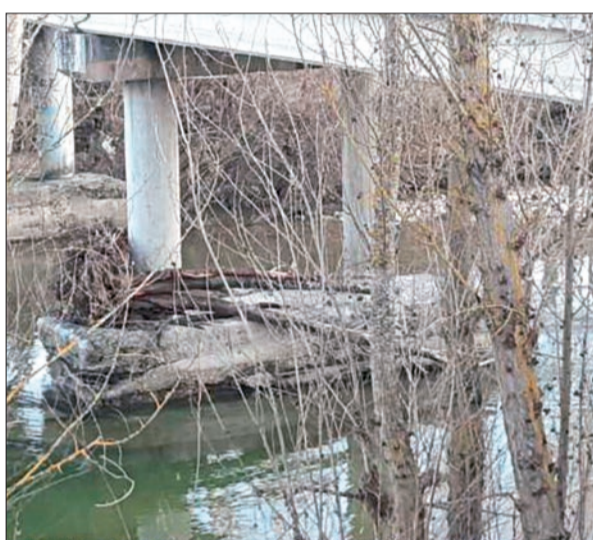
Actuación en el puente que une Villacomparada con Medina de Pomar.
