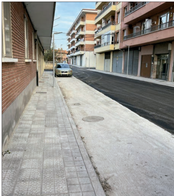
Reurbanización de la calle Basauri.
