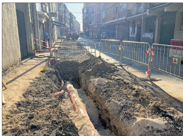
Las obras de la C/ Algorta comenzaron con la sustitución de las redes subterráneas.
