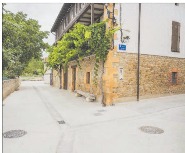
Obras en el barrio de Villacomparada.
