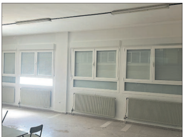
En el colegio San Isidro II se han sustituido 16 ventanas en la fachada este del edificio.
