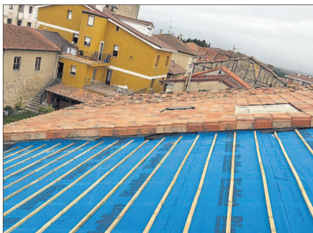
Obra de rehabilitación de cubierta en el IES La Providencia.
