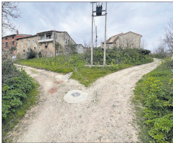
Antes y después de las obras en la calle El Molino en el Barrio de Pomar.
