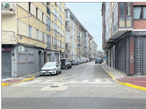
Reparación llevada a cabo en la calle San Ignacio.
