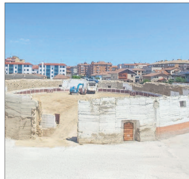
Estado de la plaza de toros de la ciudad tras la demolición del graderío.
